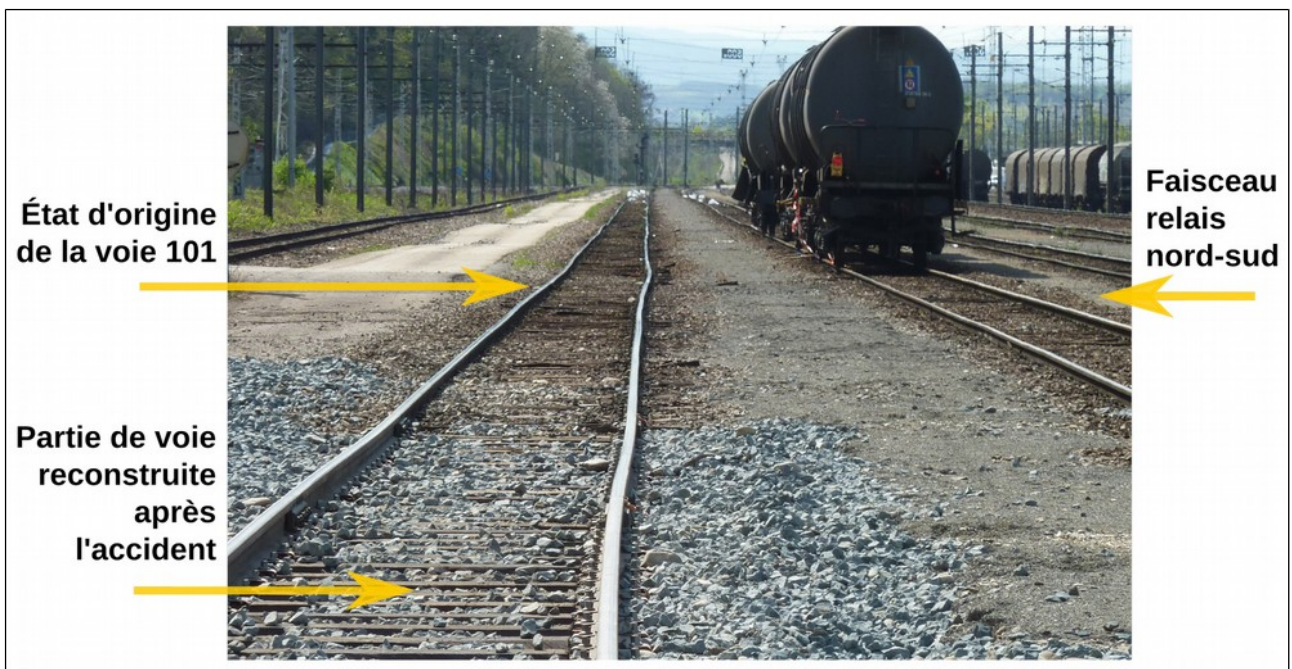
Figure 7 : l'état général de la voie en avril 2017
