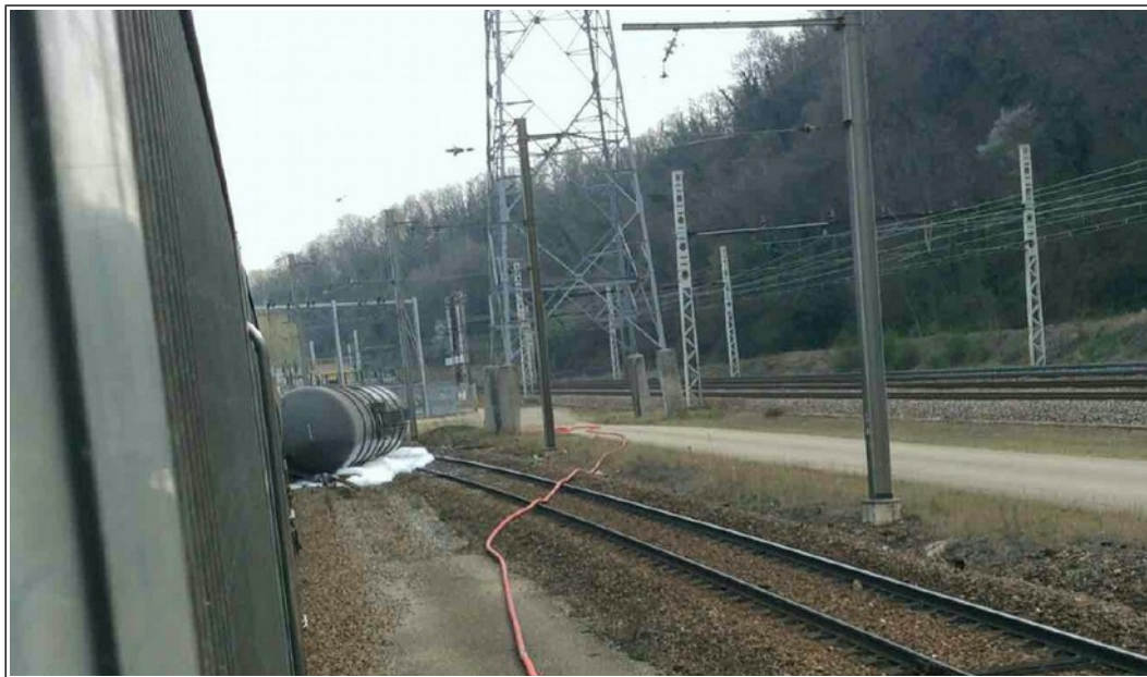
Figure 1 : le premier wagon qui a déraillé vu de la cabine de conduite (en cours d'intervention des secours)
