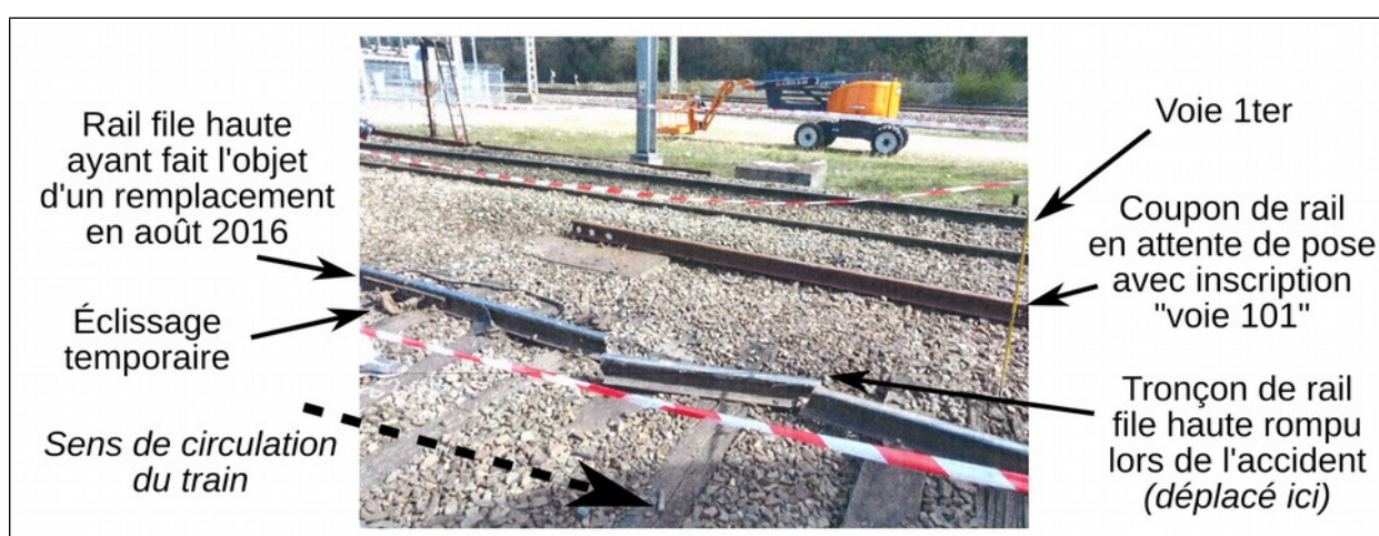
Figure 16 : le rail file haute rompu
