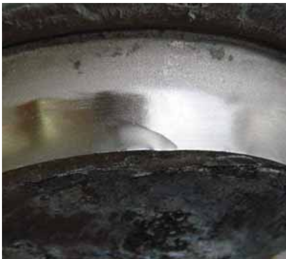
Photo 13: Congé de raccordement côté rupture
