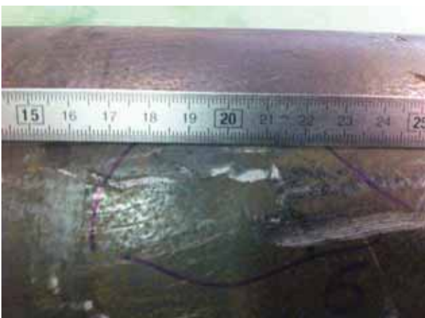
zone 6 avant décapage
