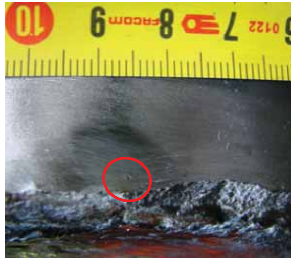
Photo 12: Défaut de surface n°3 après décapage
