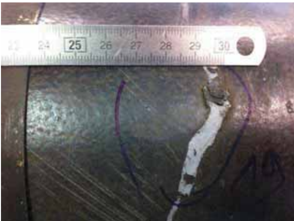
zone 19 avant décapage
