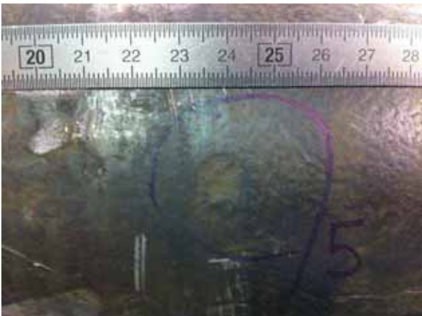
zone 5 avant décapage
