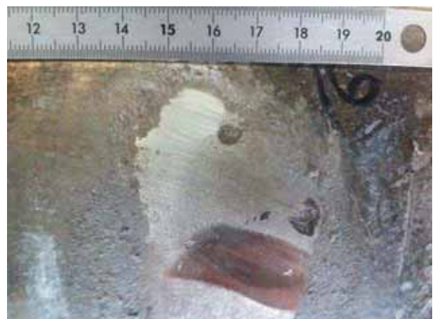
zone 16 et 17 après décapage
