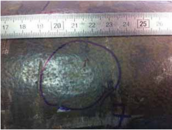
zone 7 avant décapage
