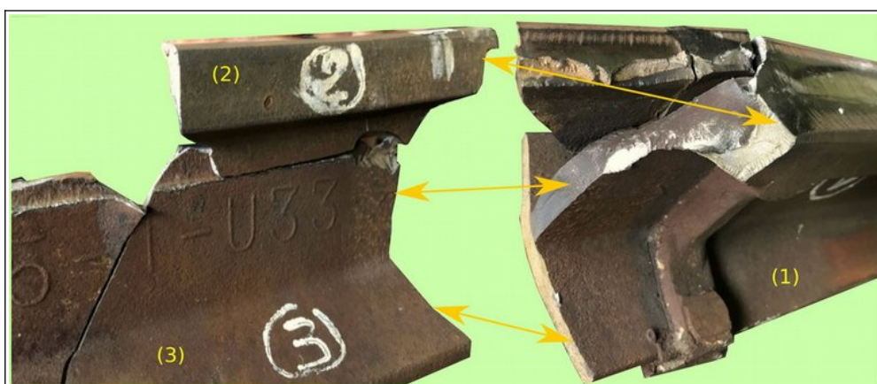
Figure 16 : fissuration transversale à proximité de la soudure aluminothermique avec les coupes de rail 46E2
