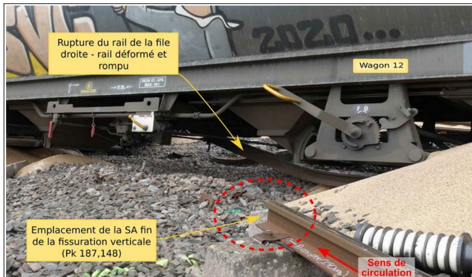
Figure 29 : vue au niveau de la rupture
