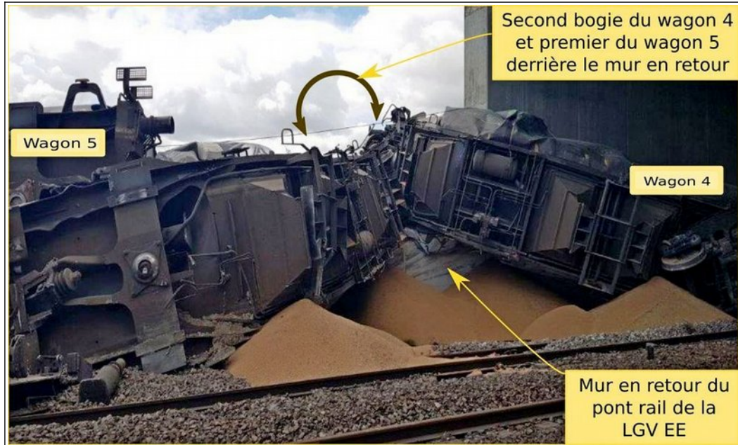
Figure 21 : vue des wagons 4 et 5 « accrochés » sur l'angle du mur en retour du pont-rail (Source BEA-TT)
