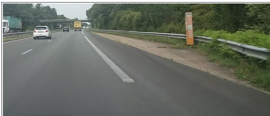
Figure 12 : Poste d'appel d'urgence en aval de la zone de l'accident (source : Google maps)
