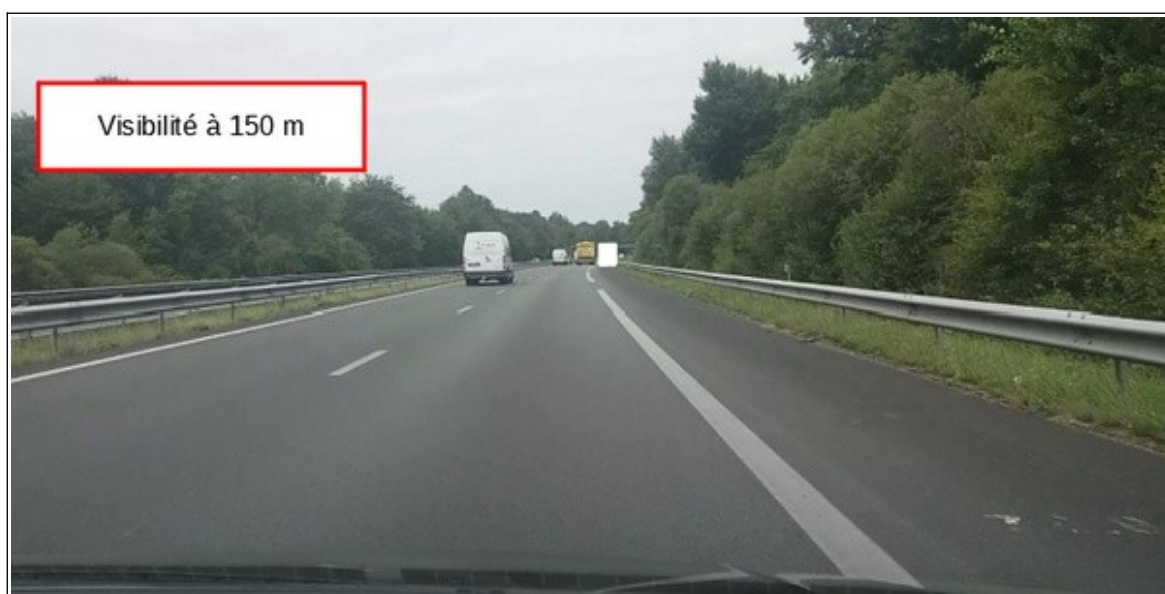
Figure 14 : Visibilité à 150 m du gabarit dessiné d'un camion sur la BAU (source : Google maps)
