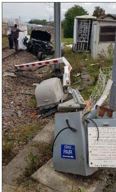
Figure 26 : Fût de la demi-barrière après l'accident Photo SNCF Réseau
