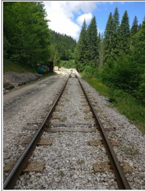
Fig 6 - Vue sur la gare de Fontaine Ronde depuis l'emplacement des véhicules au départ de leur dérive (photo BEA-TT)
