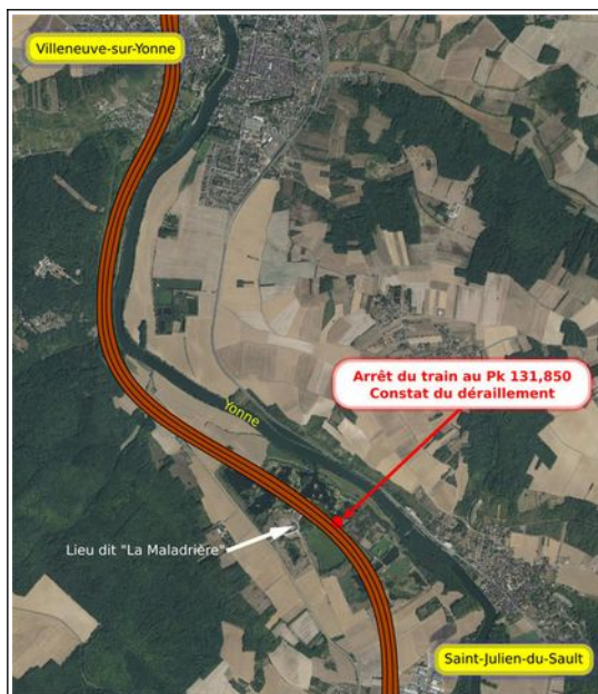
Figure 6 : Lieu de l'accident entre Villeneuve-sur-Yonne et Saint-Julien-du-Sault - Pk 134,64 (Source GoogleMap modifiée BEA-TT)
