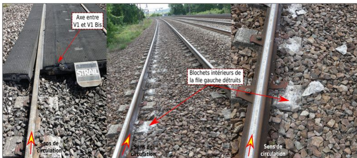
Figure 26 : Blochets détruits après le déraillement du premier essieu (Source BEA-TT)
