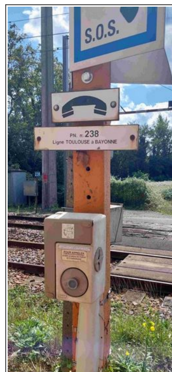
Figure 13 : le téléphone d'alerte du PN source BEA-TT, photo prise en septembre 2023
