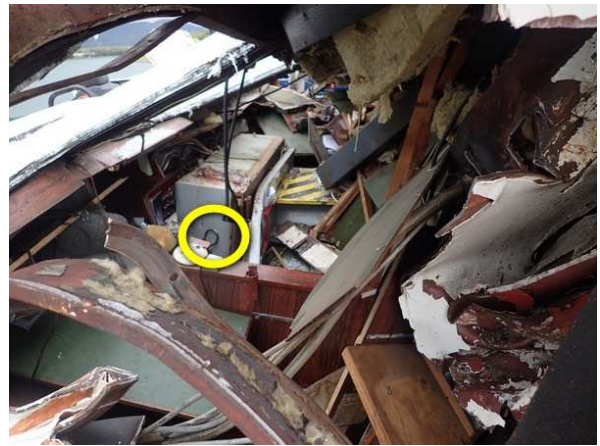
Vue de l'intérieur de la timonerie avant bâbord Commande hydraulique de secours (voir 3.8)
