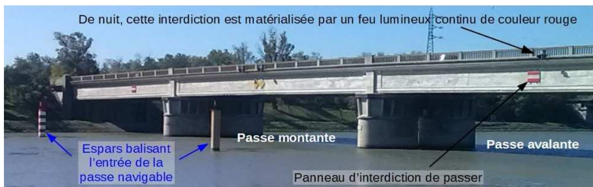
Pont routier, vue aval depuis la berge en rive gauche
