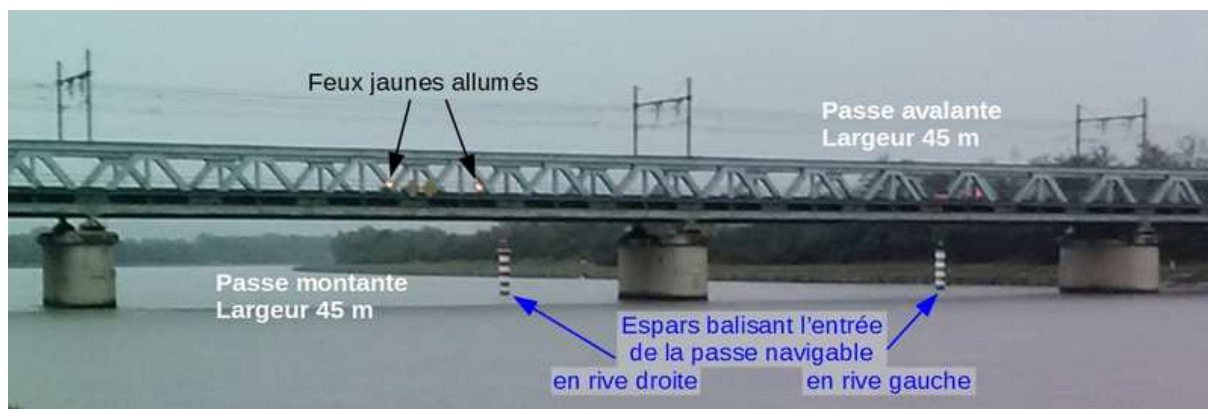
Pont ferroviaire, vue aval
