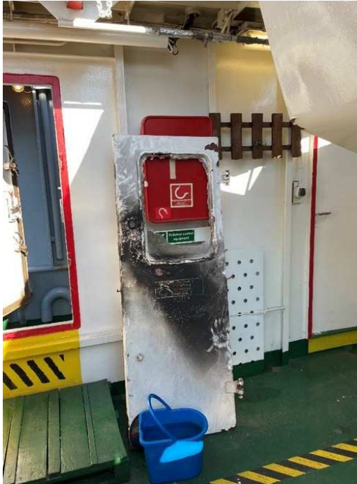
Porte tribord de la passerelle après dépose et après découpage au chalumeau. Cette porte est également visible sur les photos au 2.4
