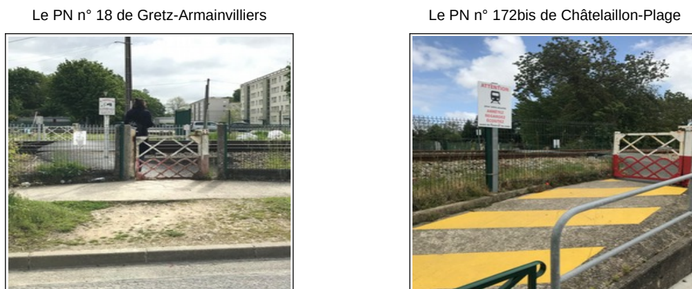
Figure 25 : illustrations des deux PN concernés par l'étude de SNCF Réseau menée en 2021 (photos SNCF Réseau)
