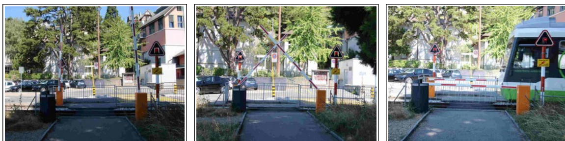
Figure 28 : illustrations d'équipement d'un PN pour piétons avec barrières en Suisse (photos BEA-TT)
