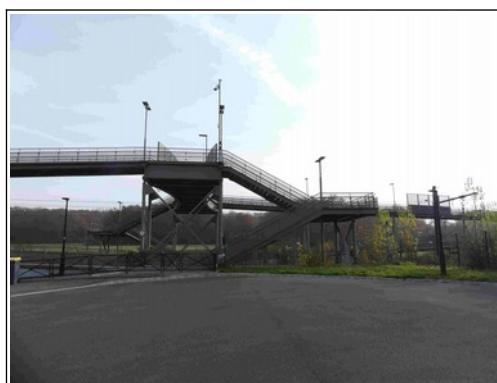
Passage supérieur, passerelle d'accès au collège
