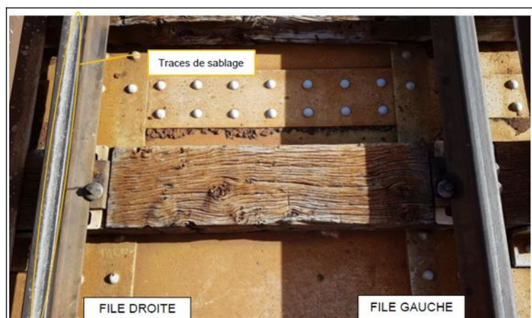
Fig 41 : Traces de sablage sur la file droite (source SNCF)
