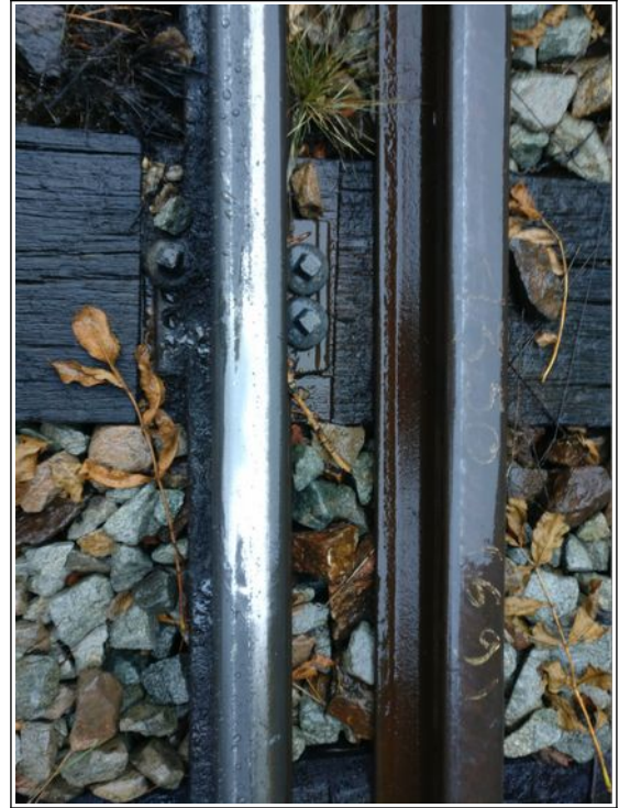
Fig 68 : À l'entrée du tunnel de La Castagnol, fin novembre 2021 : rail de circulation en l'état / même rail après nettoyage rapide (photos BEA-TT)
