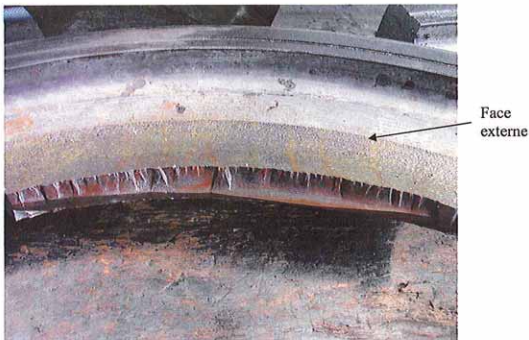
Photo 20 : Roue A1 fissure débouchante
