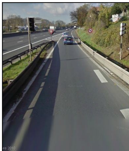
Figure 8 : La voie d'insertion de la RD 25 sur l'A6. Les feux de signalisation ne sont plus fonctionnels
