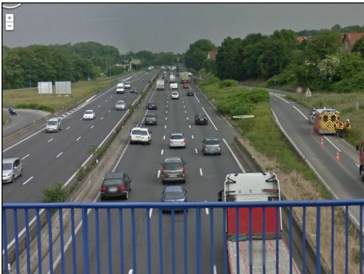
Figure 6 : Vue de l'A6 vers Paris (sens de circulation des véhicules accidentés), avec, au fond à droite, la bretelle d'entrée de l'échangeur n° 6
