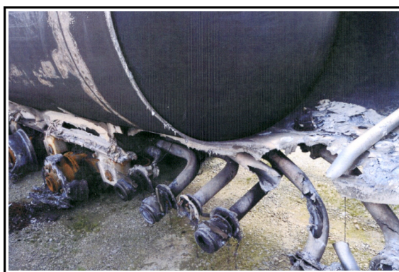
Figure 9 : Le flanc avant droit de la citerne
