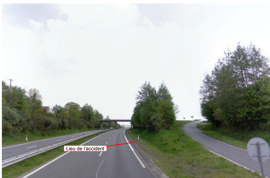
Figure 2 : Vue de la RN 12 à proximité du lieu de l'accident
