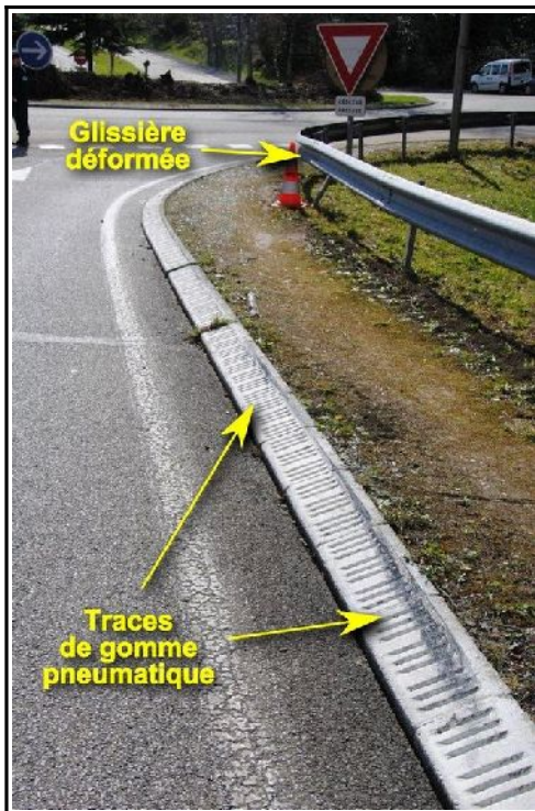
Figure 13 : Vue du côté droit de la bretelle au niveau du rond-point
