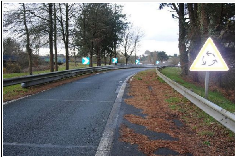
Figure 7 : Vue du virage de la bretelle de sortie Aucune trace de freinage n'est visible sur la chaussée
