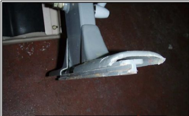
Figure 25 : Vue rapprochée d'une ferrure intérieure
