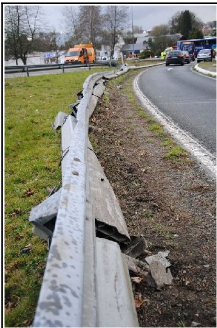
Figure 11 : Vue de la dernière section de la glissière de sécurité couchée et écrasée
