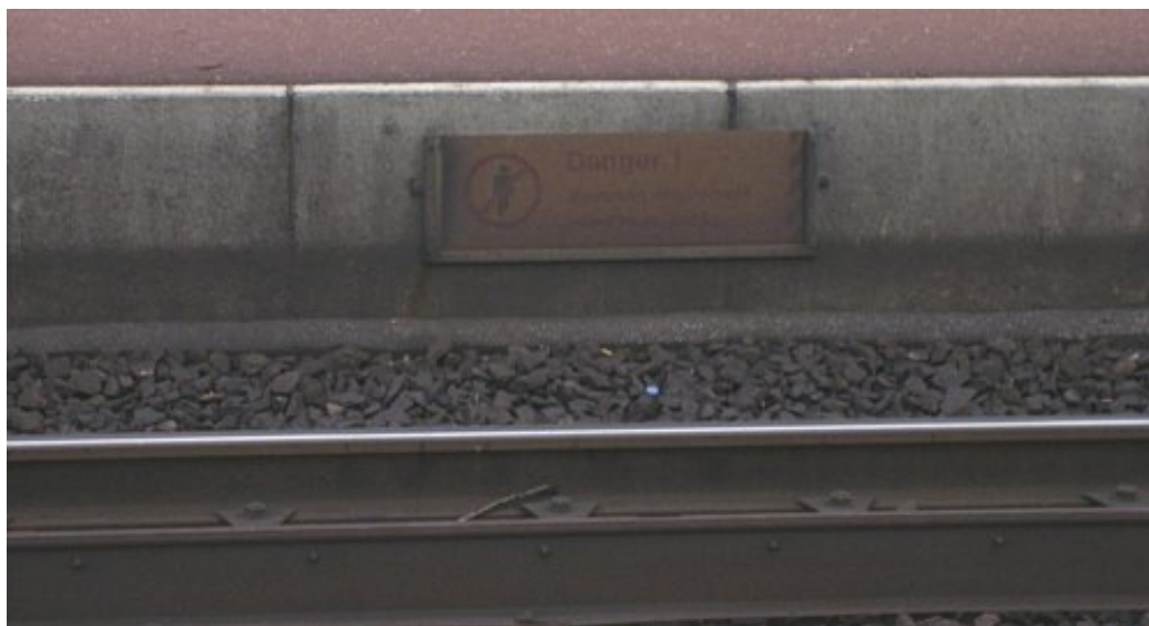
Panneau de rappel d'interdiction de traverser les voies (situé en bordure de quai)
