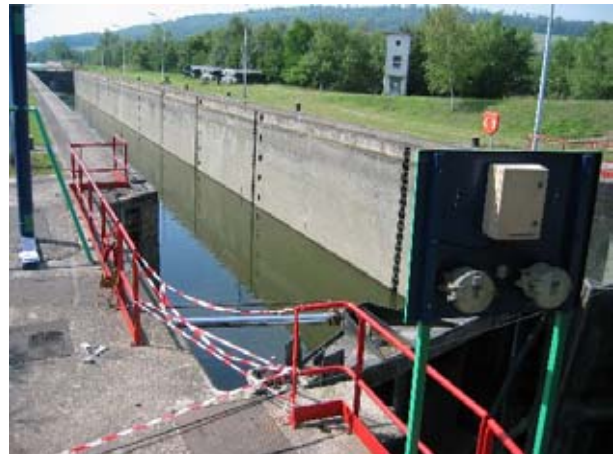
Ecluse de Blénod lès ponts à Mousson
