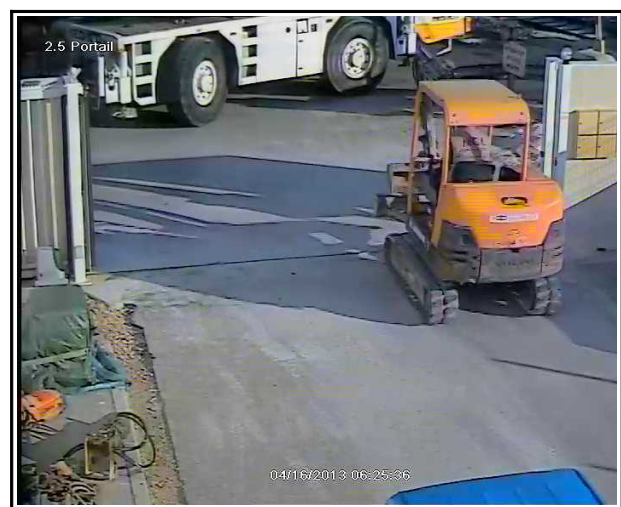
Figure 28 : Vue du portail à T0-1'04''
