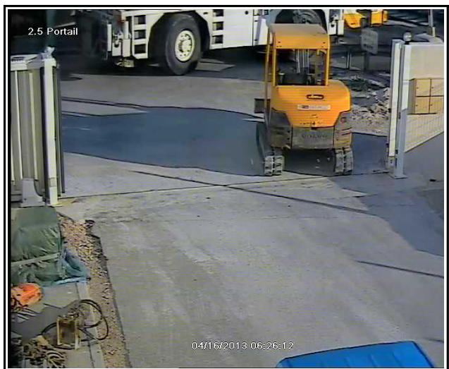
Figure 36 : Vue du portail à T0-28''
