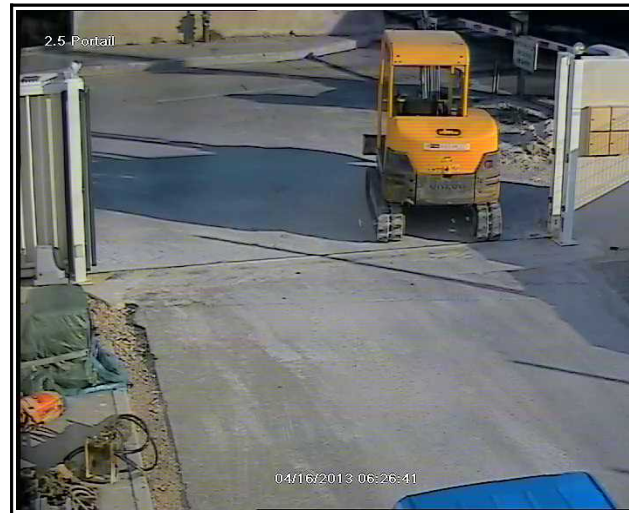
Figure 44 : Vue du portail à T0+01"
