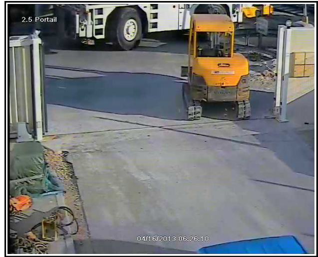
Figure 34 : Vue du portail à T0-30''
