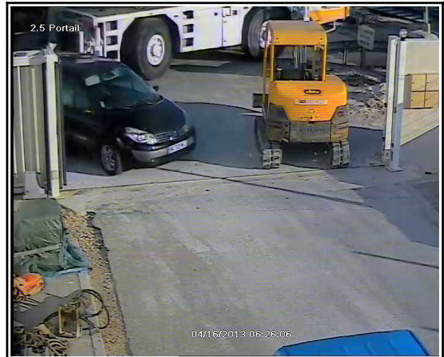
Figure 32 : Vue du portail à T0-33''
