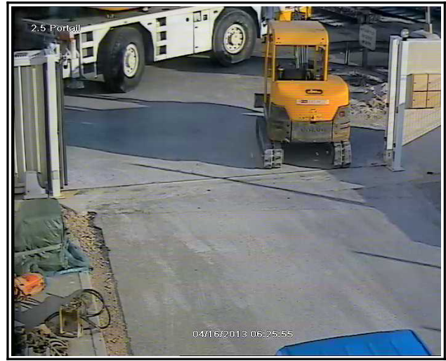
Figure 30 : Vue du portail à T0-45''
