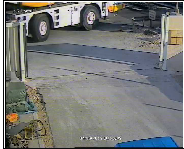
Figure 26 : Vue du portail à T0-1'31''
