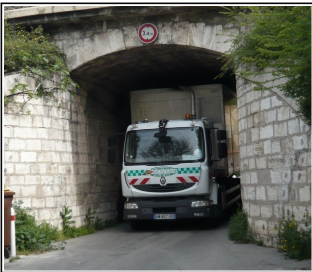
Figure 7 : Vue, en venant du passage à niveau n° 1, du passage inférieur situé au débouché du chemin du Passet sur l'allée des Grillons
