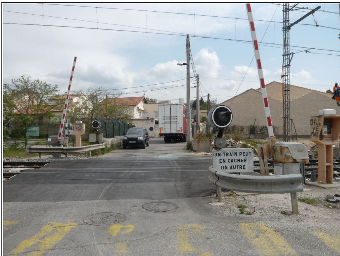
Figure 9 : Le passage à niveau n° 1 vu dans le sens de circulation de la grue mobile
