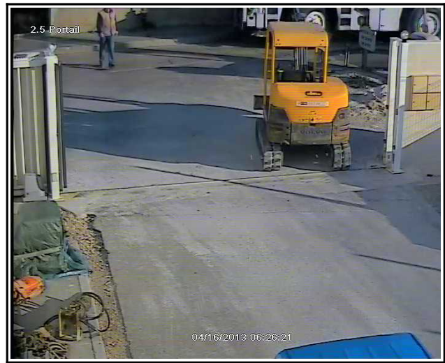
Figure 38 : Vue du portail à T0-19"
