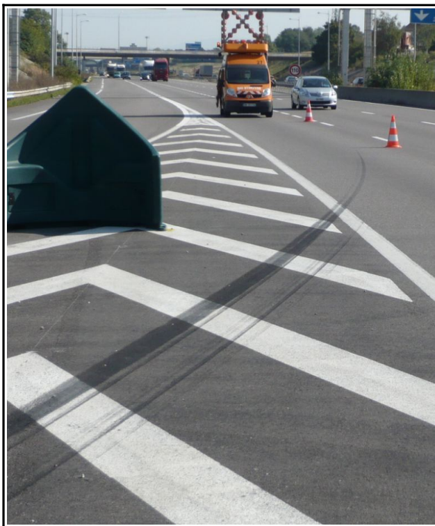
Figure 19 : Traces de pneumatiques visibles au niveau du musoir de la sortie n° 20
