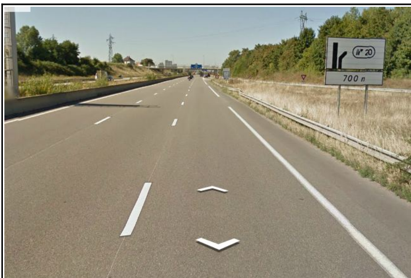
Figure 6 : Vue n° 3 – La chaussée de l'autoroute A 36 en aval de la bretelle venant de la branche nord de l'A 35
