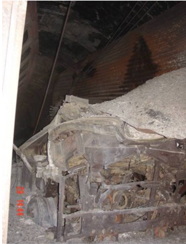
figure 34 : Dégâts subis par l'un des wagons porteurs de fret et par son chargement
