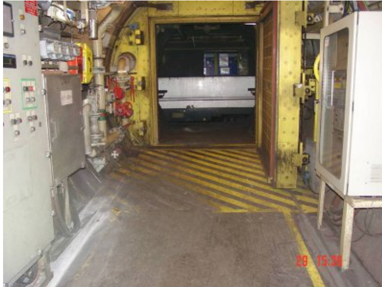
figure 40 : vue de la voiture aménagée depuis le tunnel de service à travers le rameau de communication 4898 (montrant la fenêtre par laquelle la plupart des passagers sont sortis)
